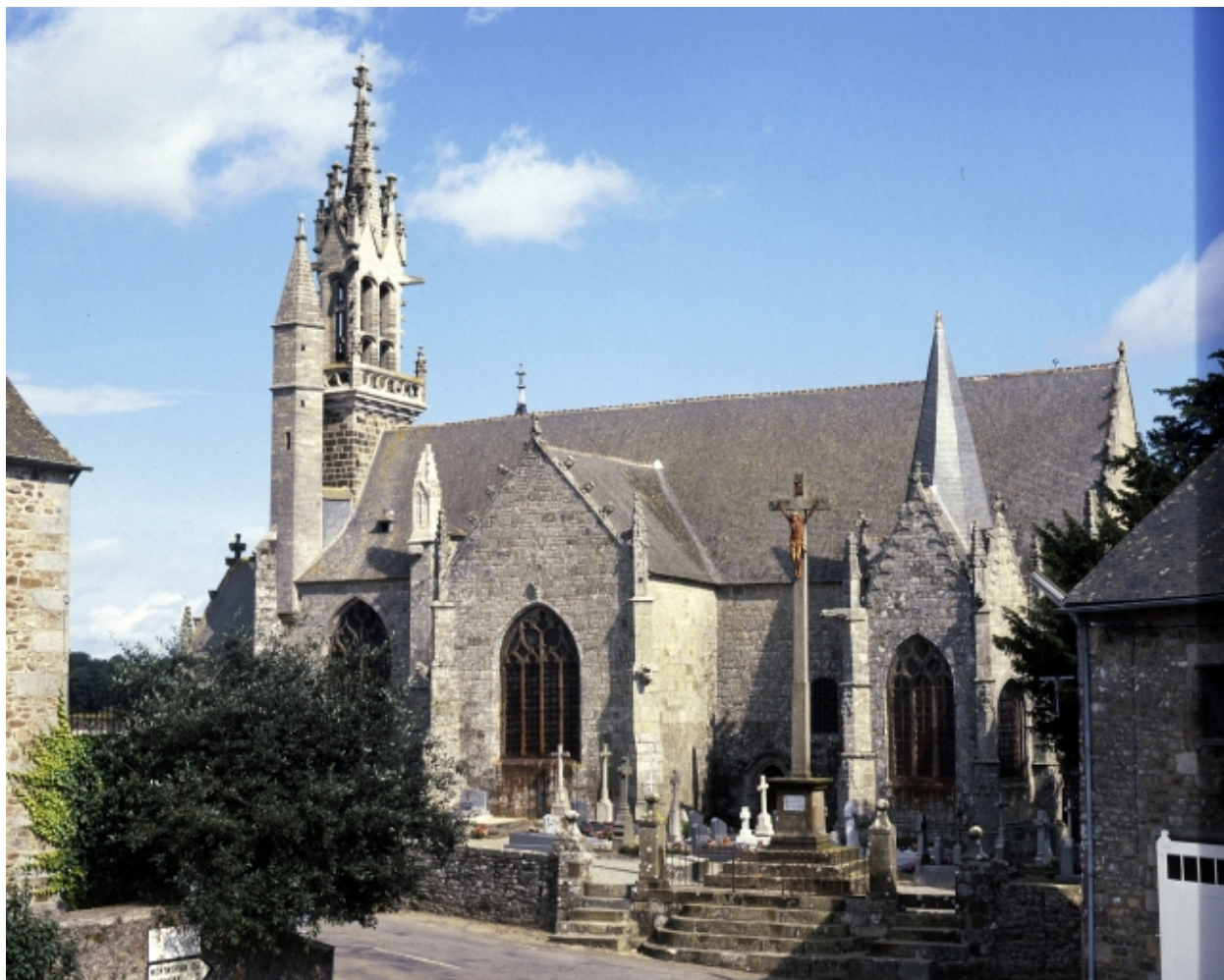
Elévation sud, partie est : vue générale
