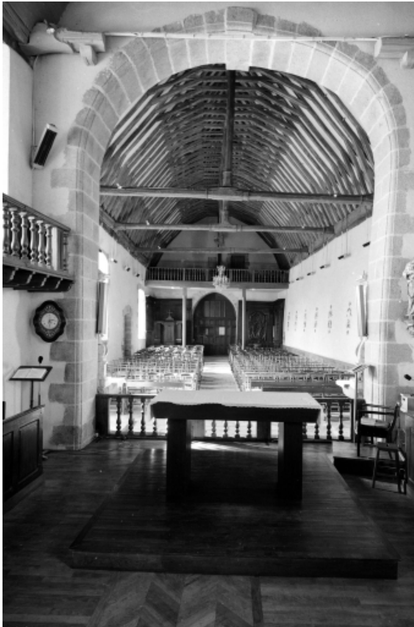
Vue générale d'est en ouest.
