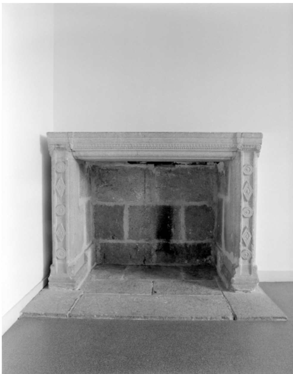
Vue générale de la cheminée, salle n°5 au 1er étage.
