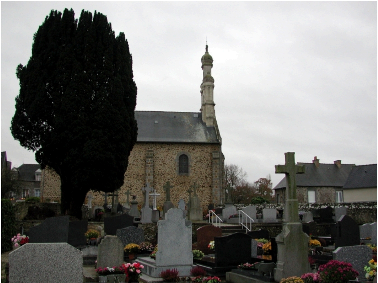
Le cimetière agrandi au milieu du 20e siècle : vue générale nord
