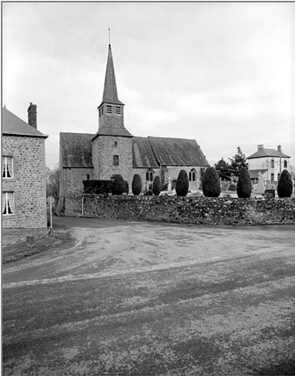
Elévation Sud-Ouest : vue générale
