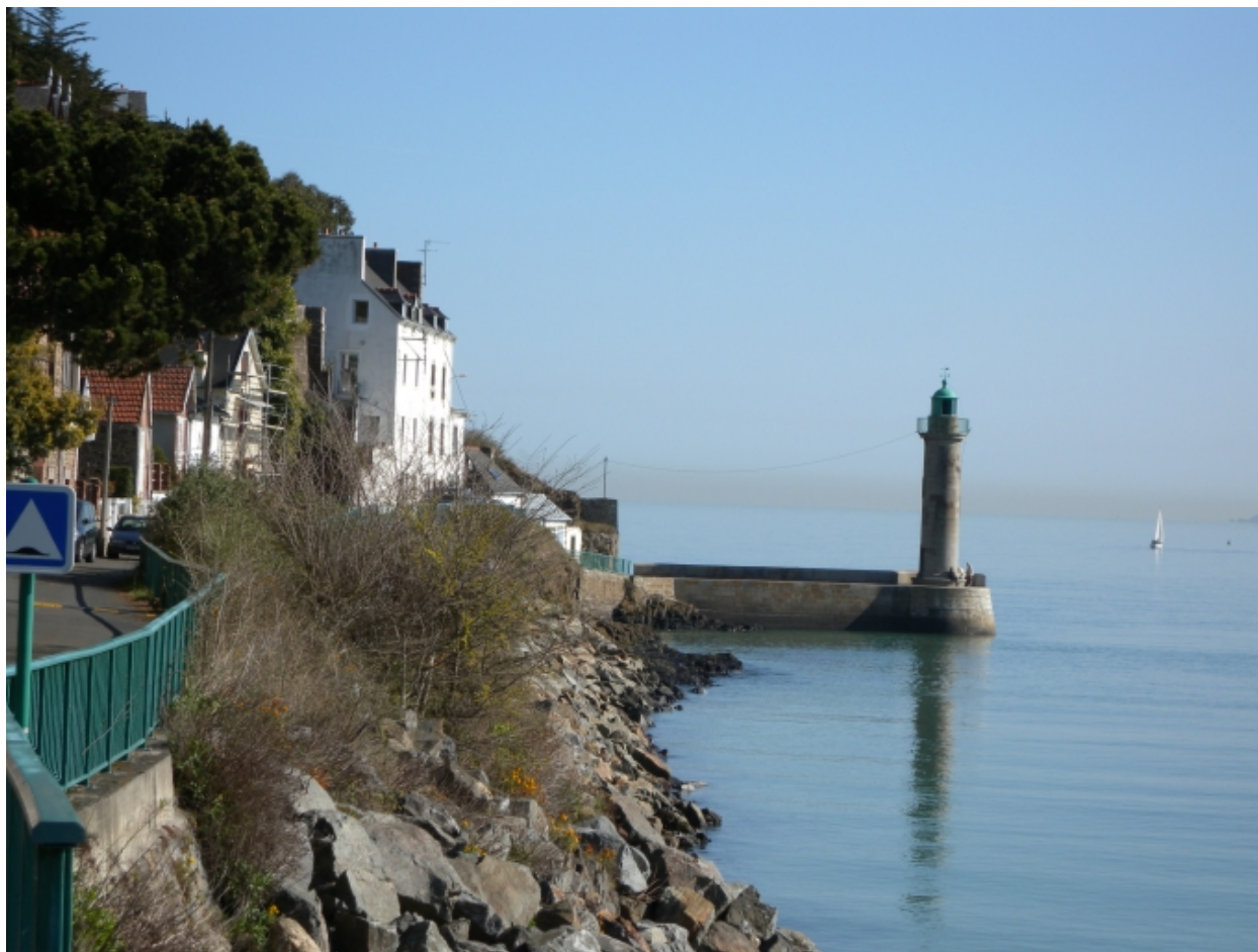
Vue des enrochements et du mur de soutènement en amont du phare
