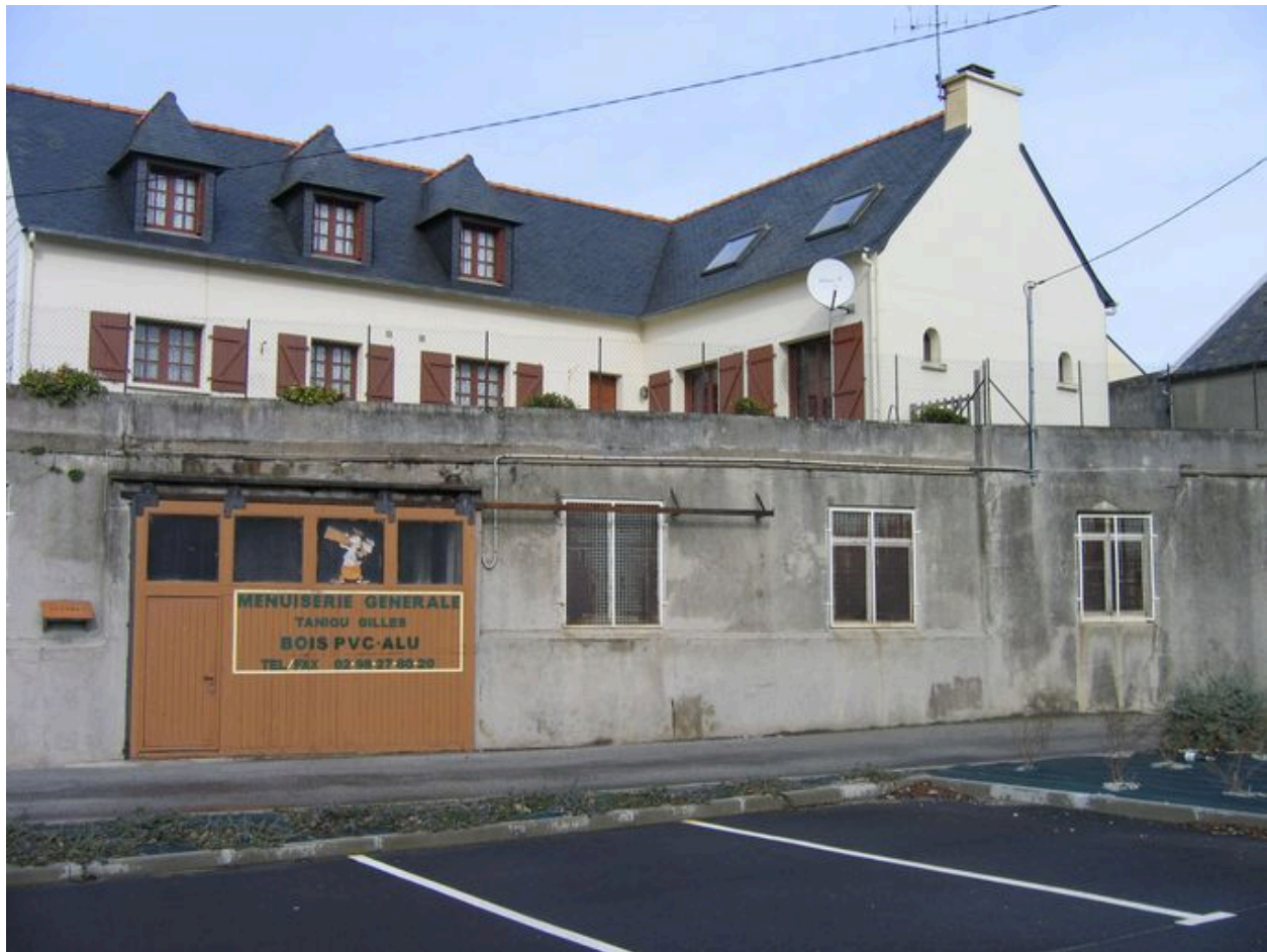
Elévation postérieure de l'ancienne conserverie Béziers
