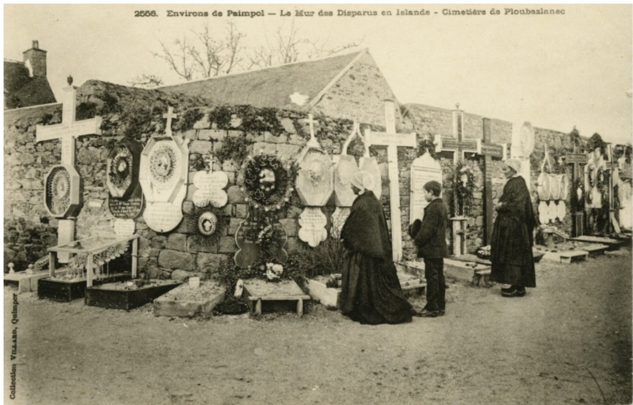
Le 'Mur des Disparus', 1er quart 20e siècle : remarquer la construction à sec du mur en moellons de granite taillé (carte postale, AD 22)
