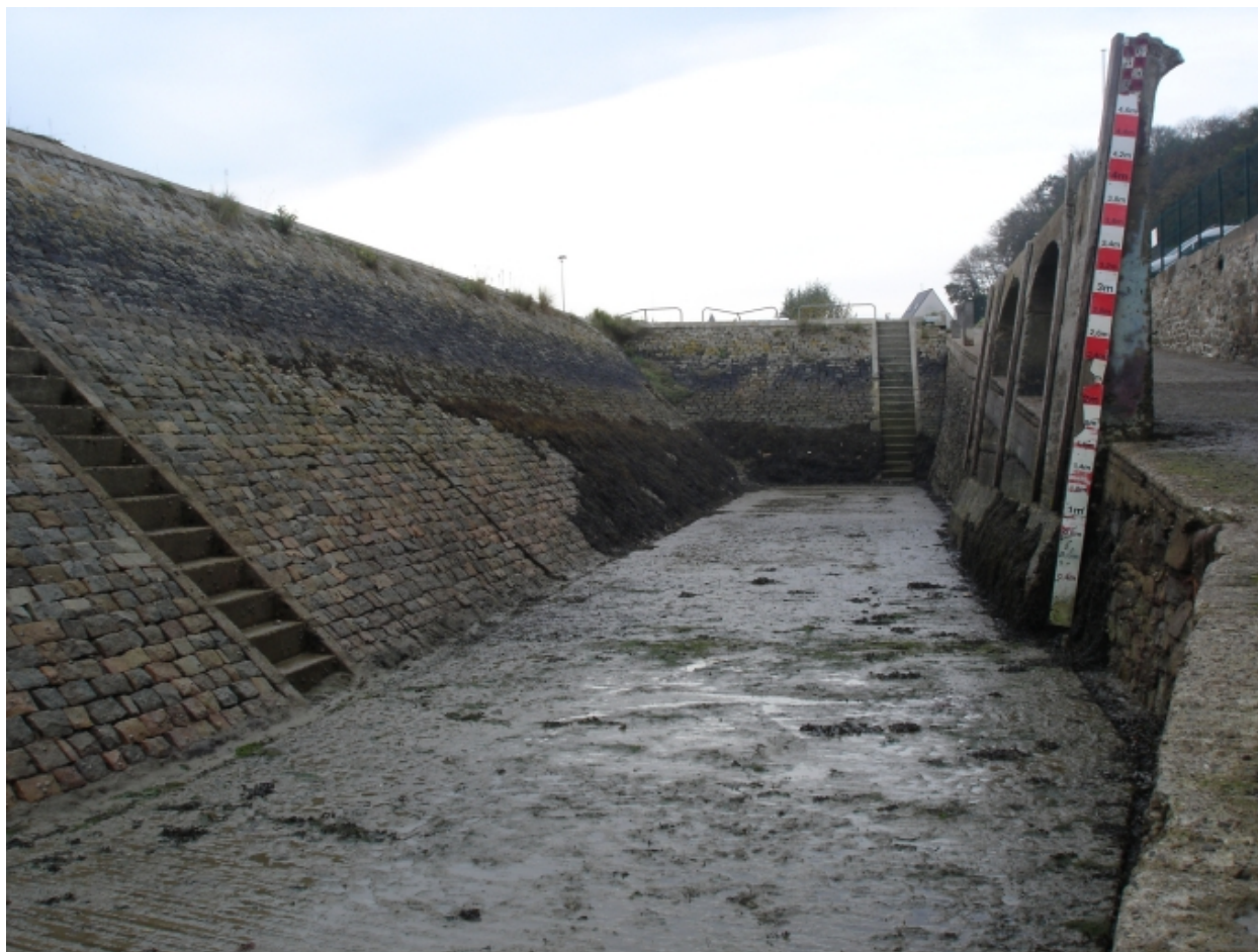
Vue générale du bassin ouvert
