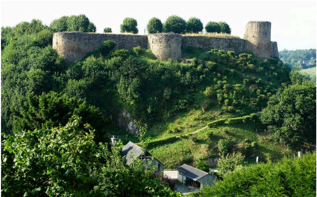
Vue générale nord du château fort (tour nord-est, tour nord et tour nord-ouest)
