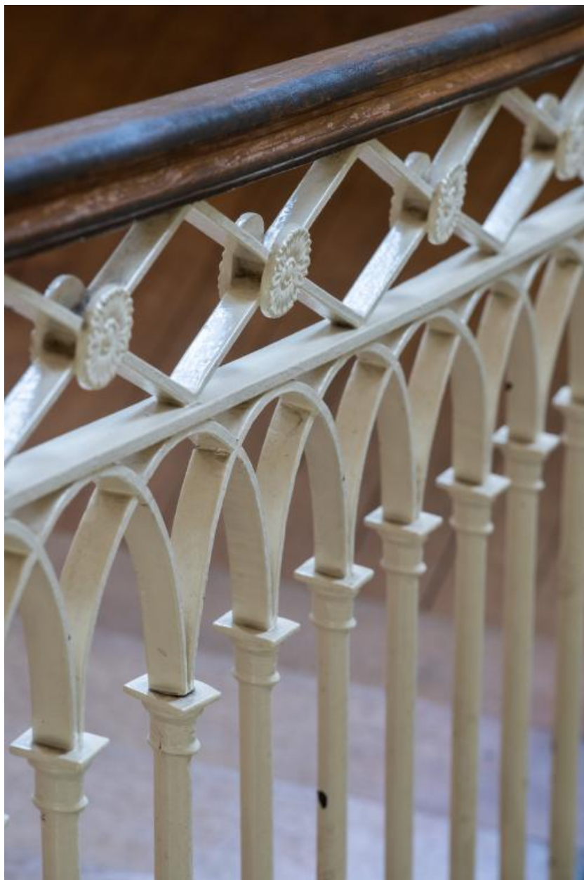
Ferronnerie de l'escalier
