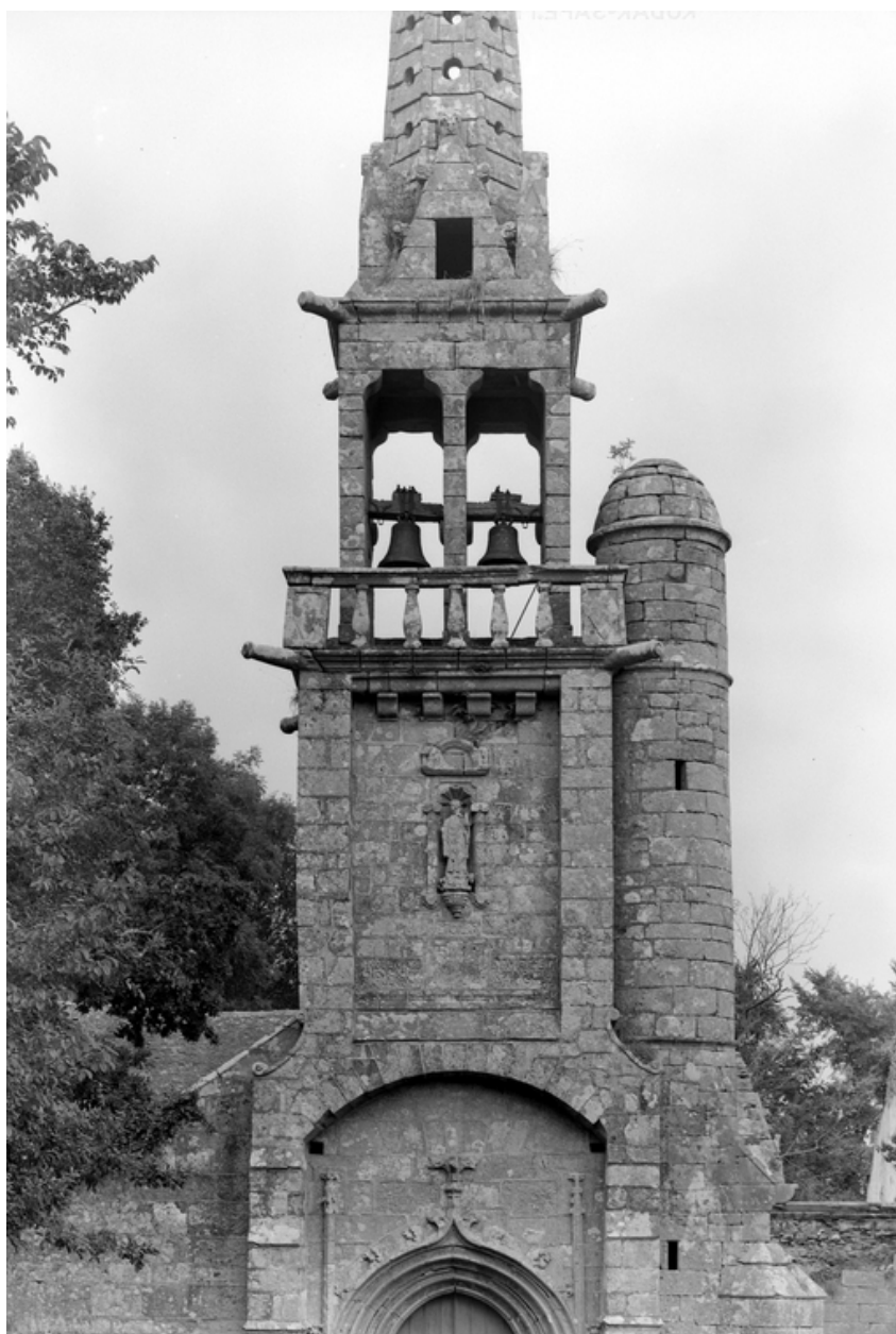
Face ouest : vue de la chambre des cloches
