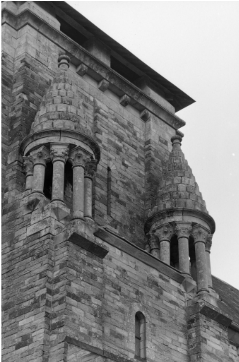
Clochetons sud de la tour, vue de détail.
