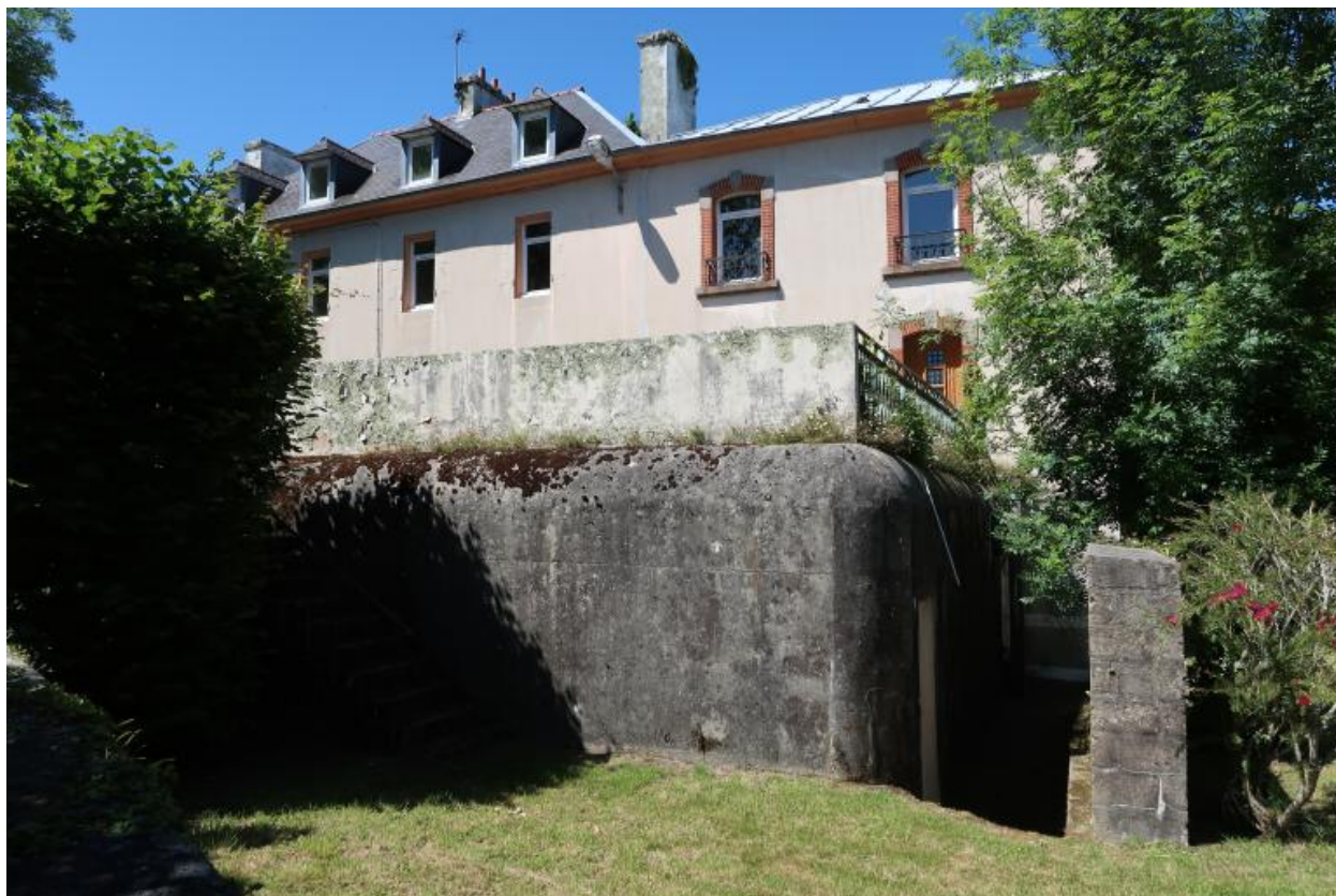
Vue générale depuis le sud-est (état en 2022)
