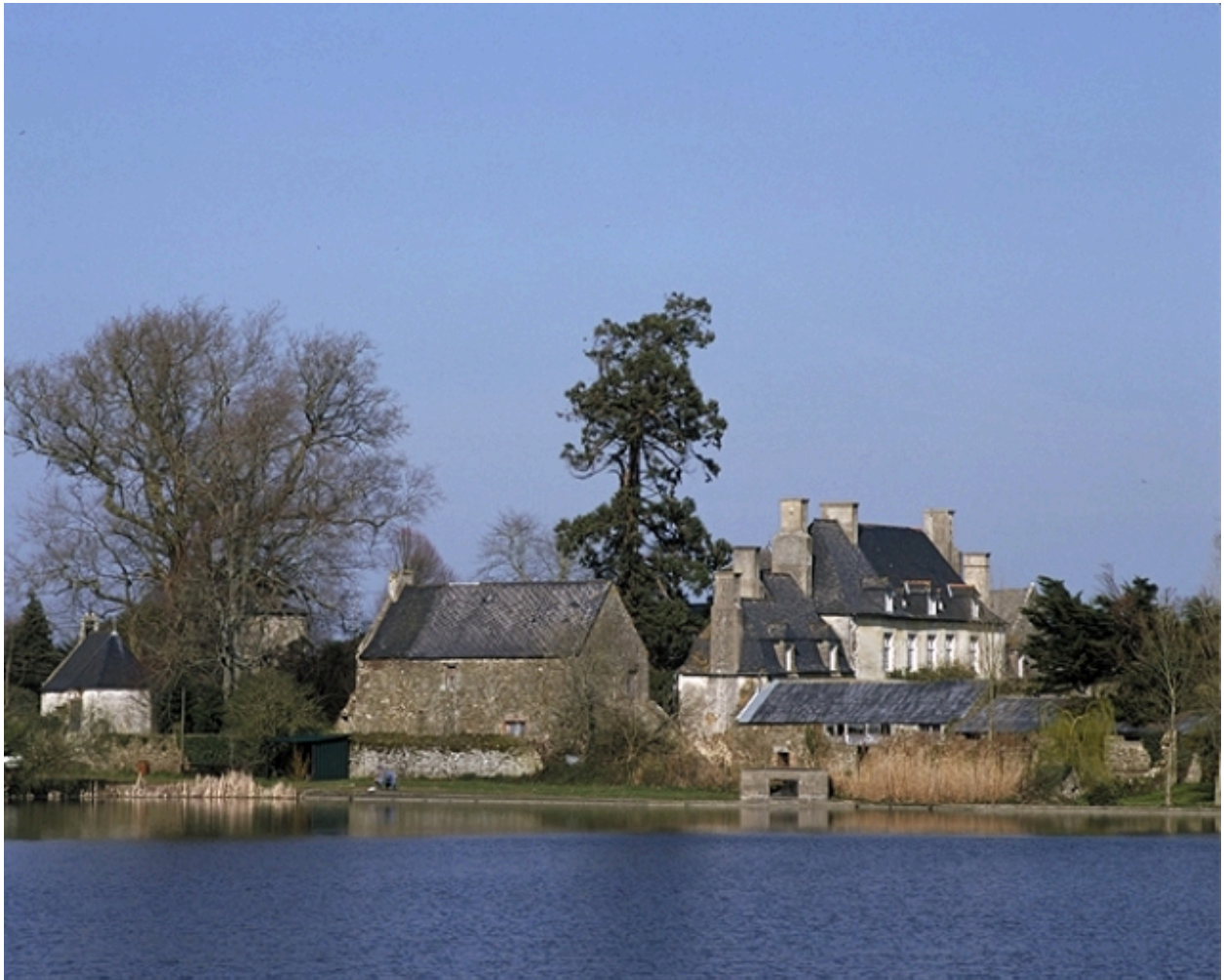
Vue de situation sud-ouest
