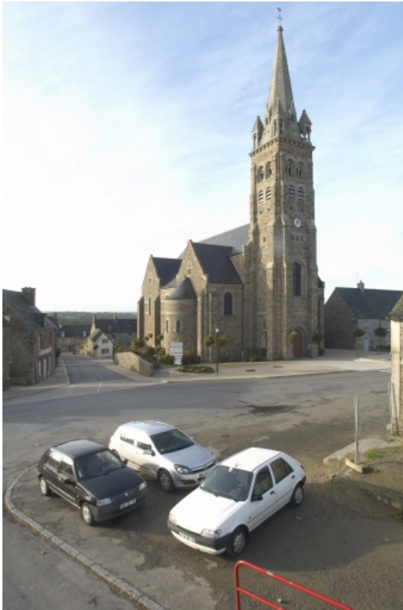
Vue de 3/4 des élévations nord et est
