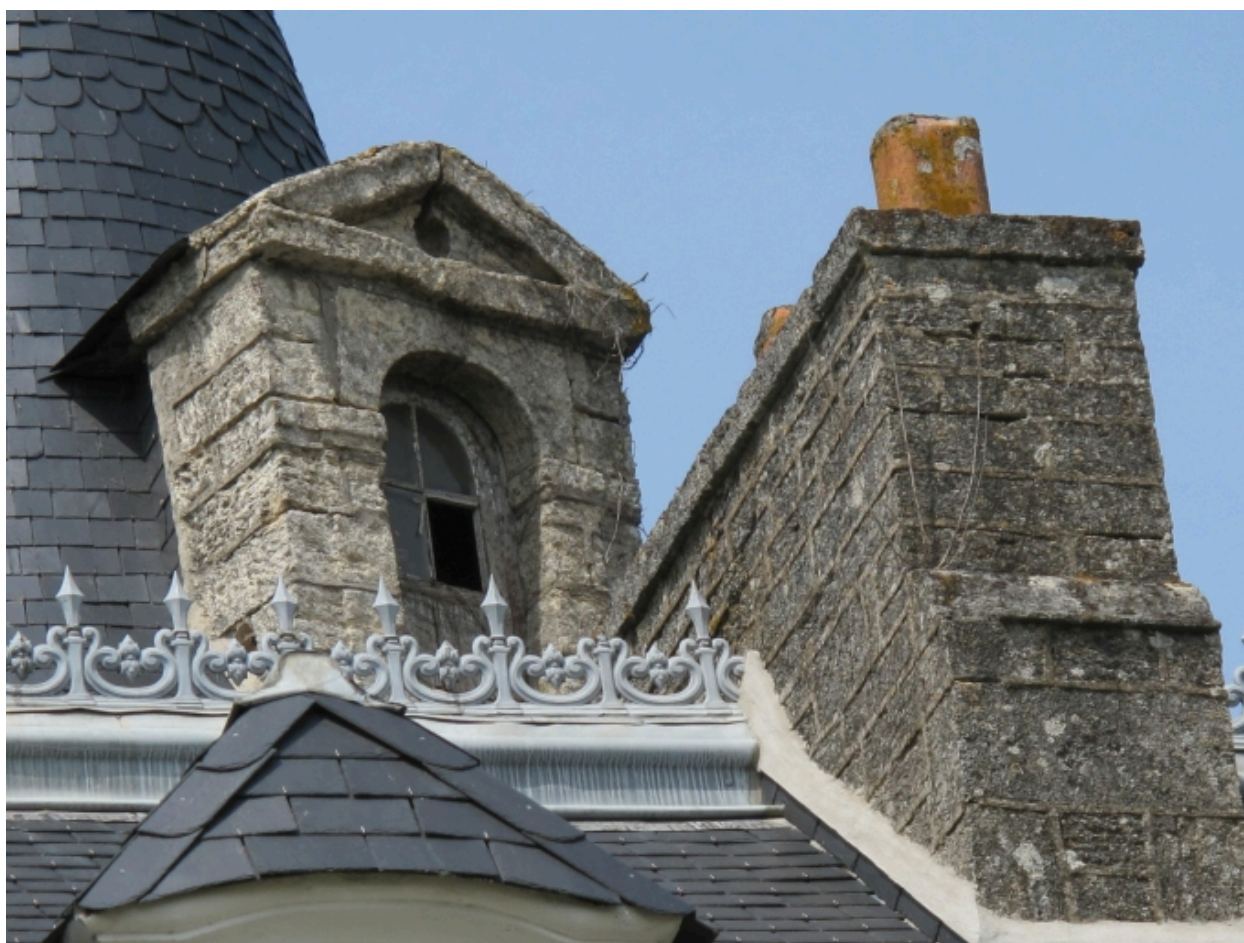
Lucarne de la tour d'escalier arrière
