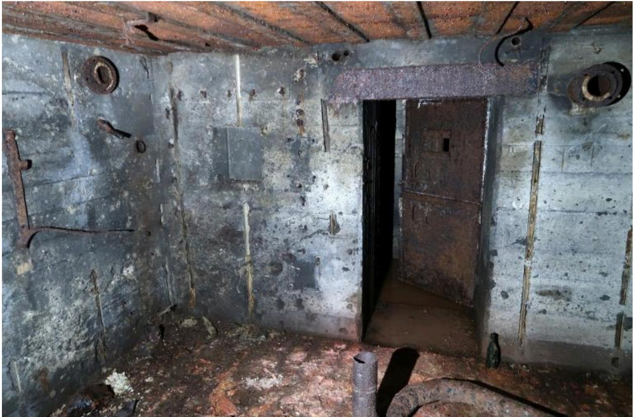
Vue de la salle de garde nord : angle nord-est, accès de la petite salle avec sa porte blindée. A gauche de la porte, niche murale et emplacement du boîtier de connexion téléphonique. Les murs sont constellés d'éclats et noircis par la fumée
