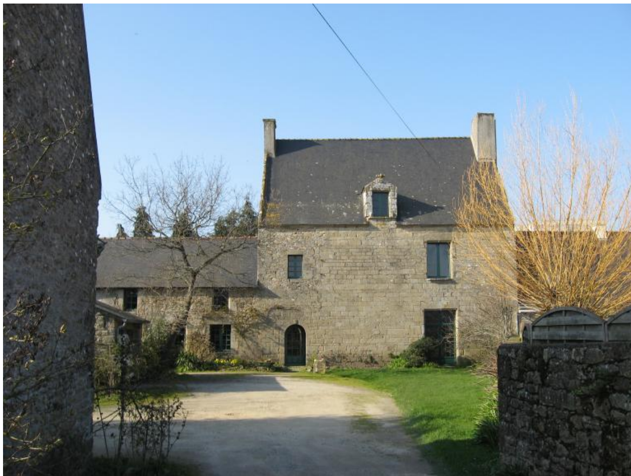
Manoir de Kerandré, façade Sud
