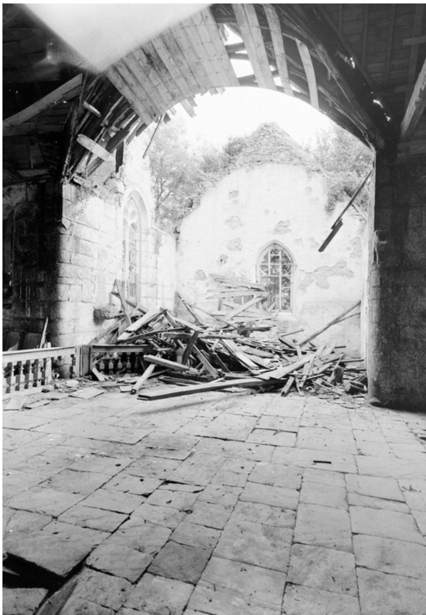
Vue intérieure du mur sud du bras sud
