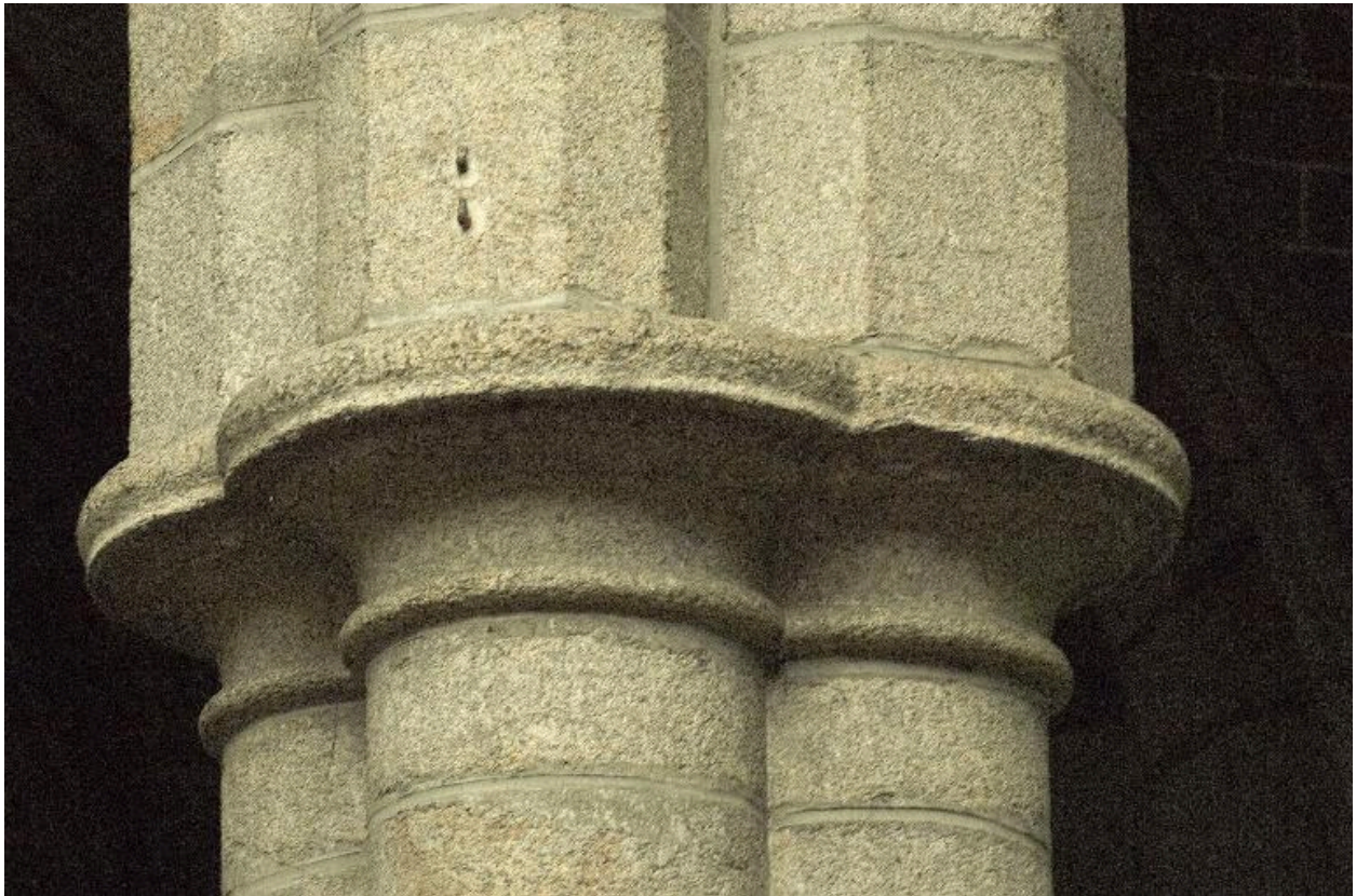
Détail des chapiteaux d'une pile du choeur
