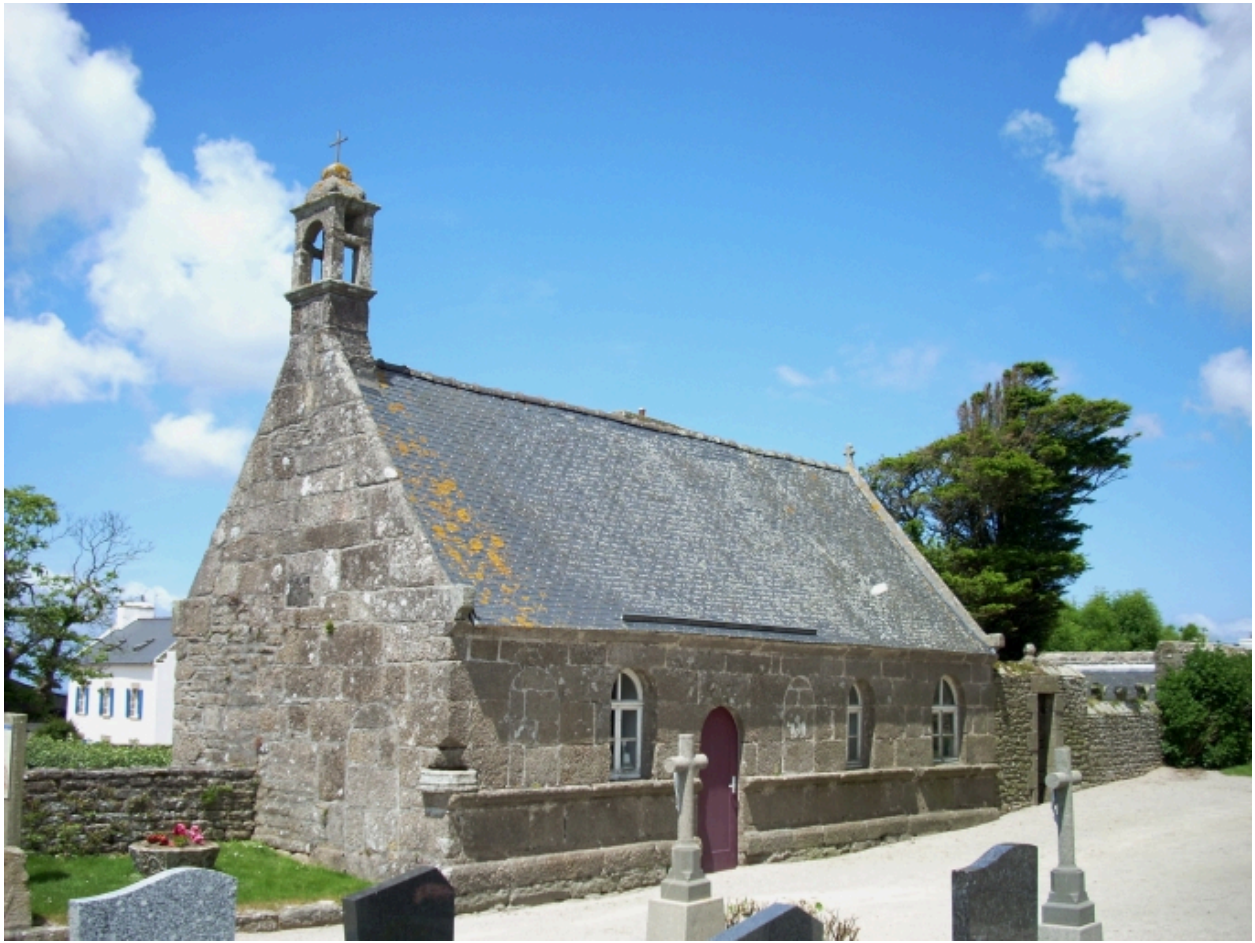
Plourin-Ploudalmézeau, église paroissiale : ossuaire, vue générale sud-est
