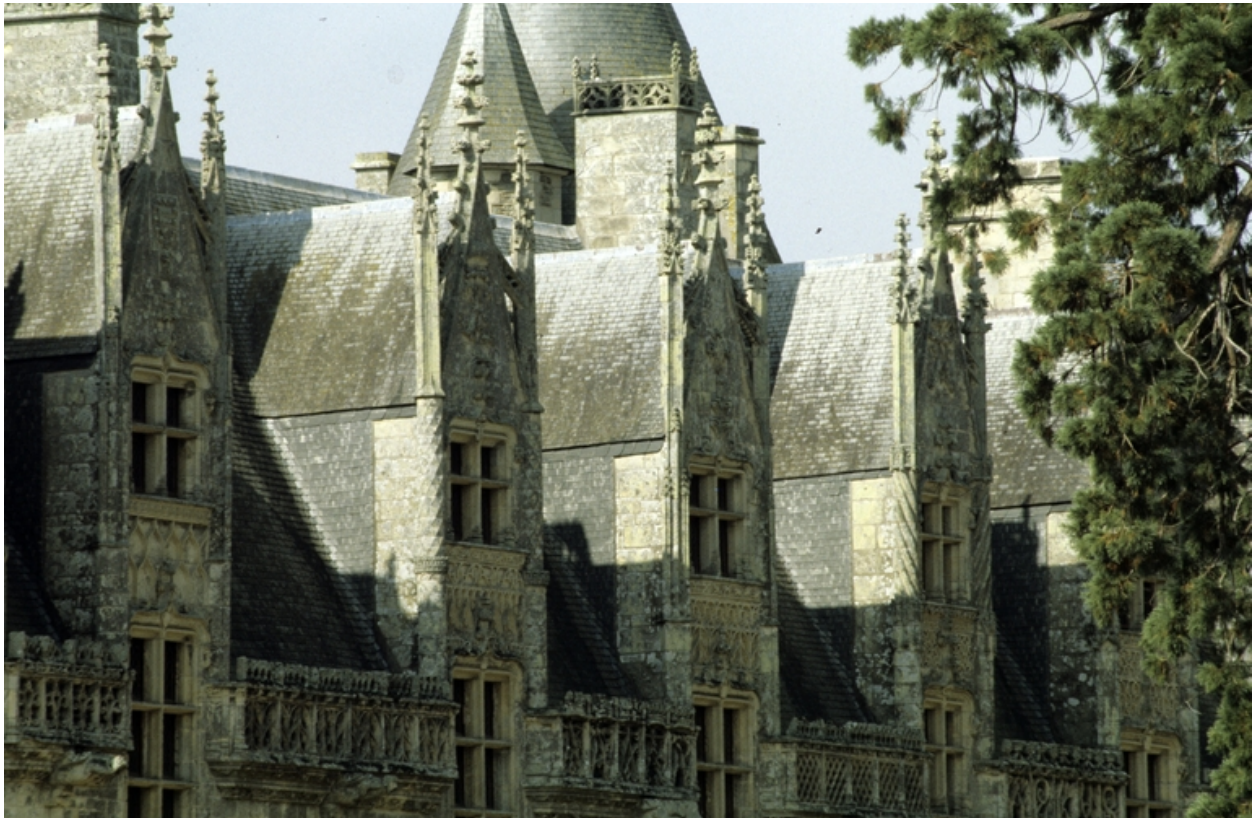
Logis, élévation sur cour : lucarnes 2 à 5 à partir du sud
