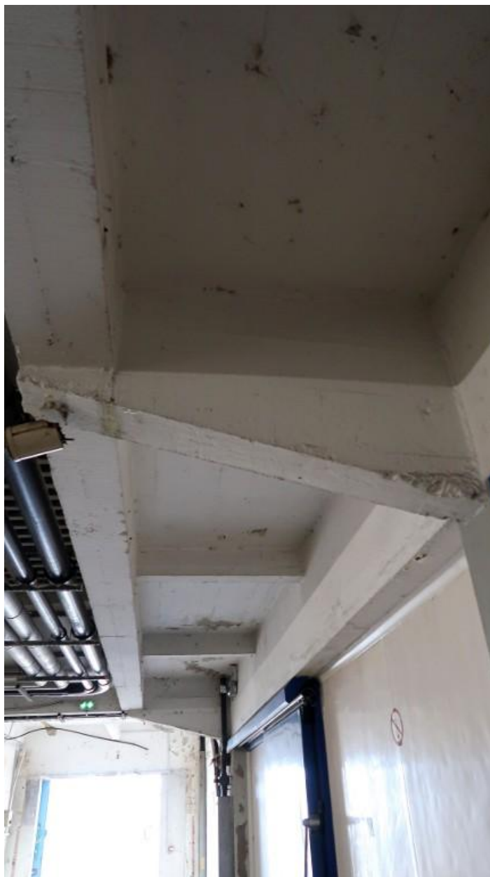
Criée de Concarneau : structure béton
