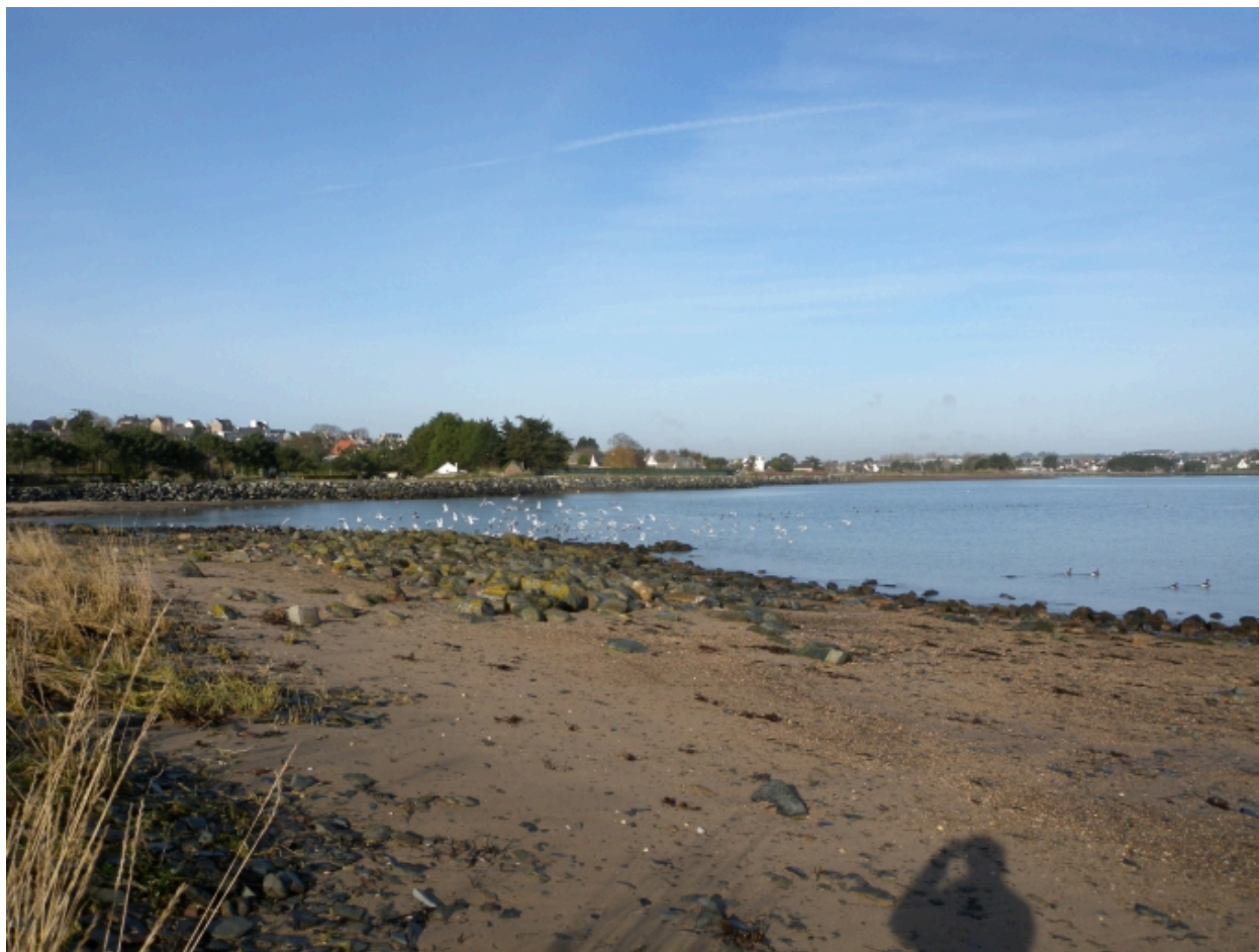
Vue des enrochements en fond de baie
