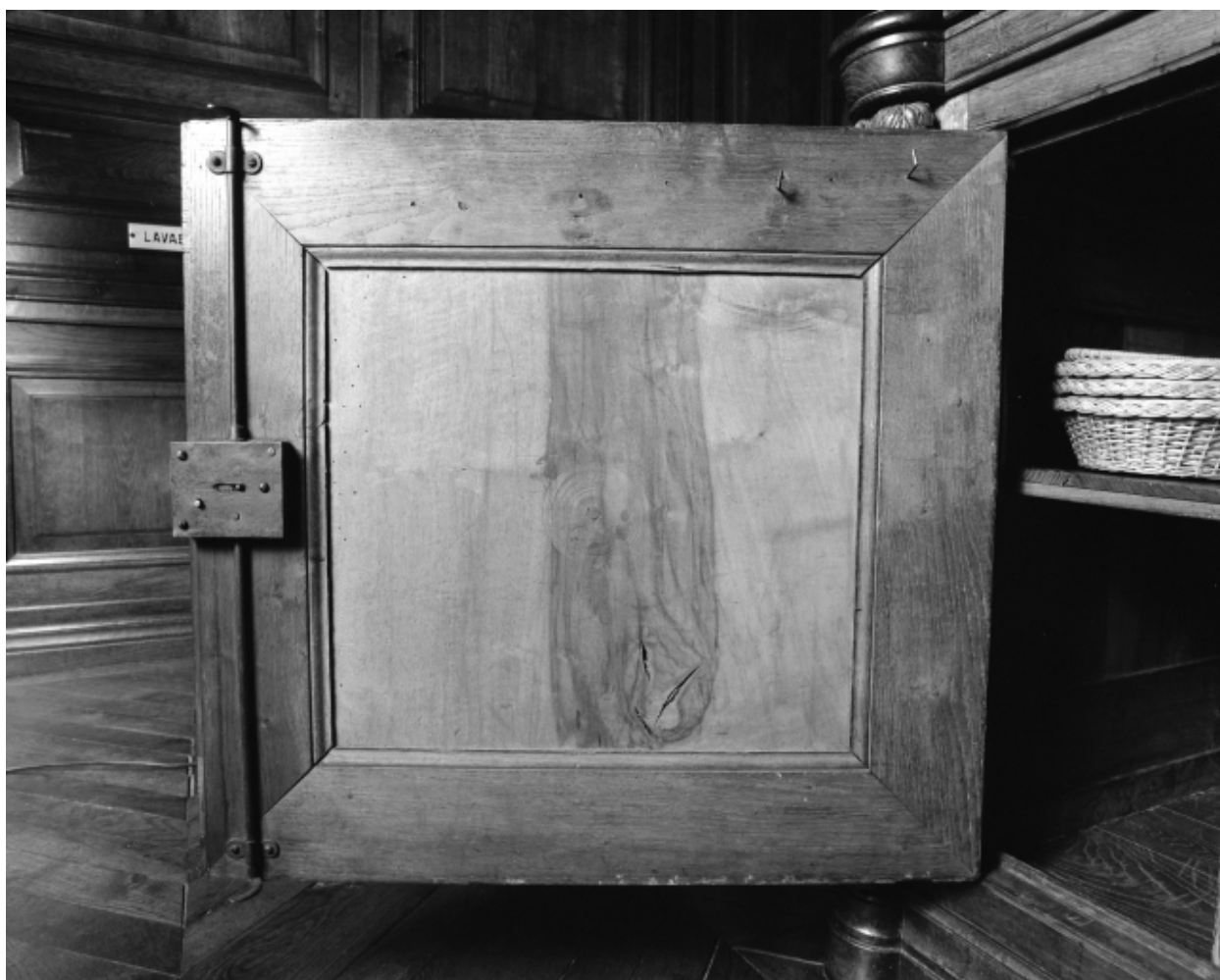
Sacristie - Détail du revers d'un panneau.
