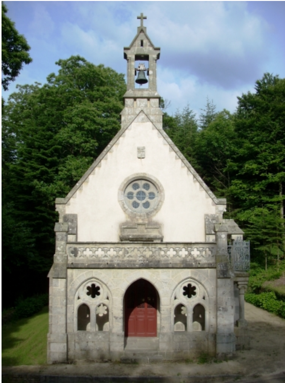
Plonéis, chapelle Sainte-Anne : élévation ouest
