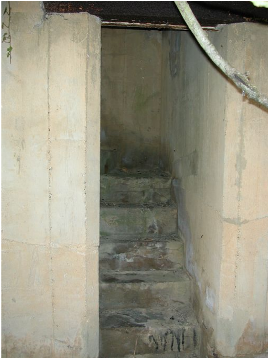
Vue de l'escalier d'accès au poste d'observation et de tir dit Tobruk-Stand situé au-dessus du bunker (état en 2002)
