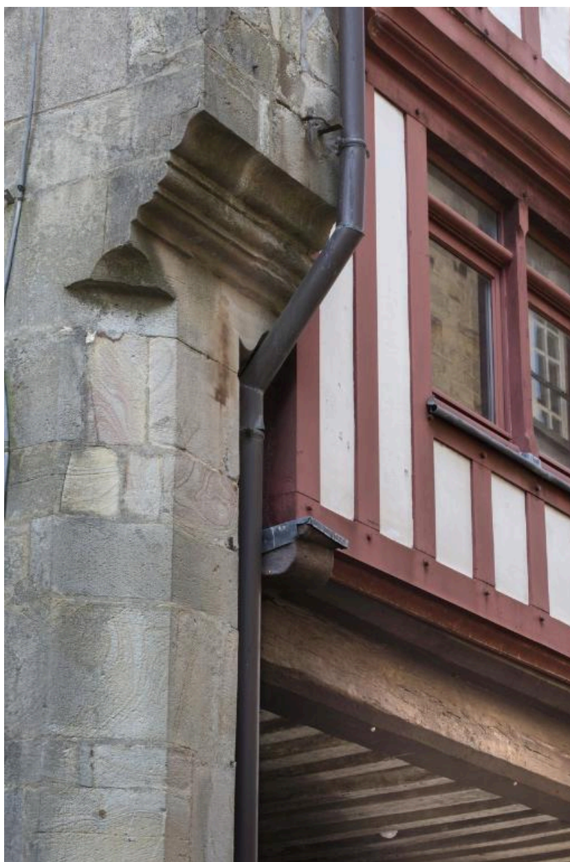
Détail de la gouttière et du mur en encorbellement.
