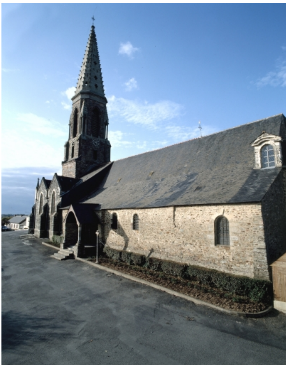
Elévation Sud-Ouest : vue générale
