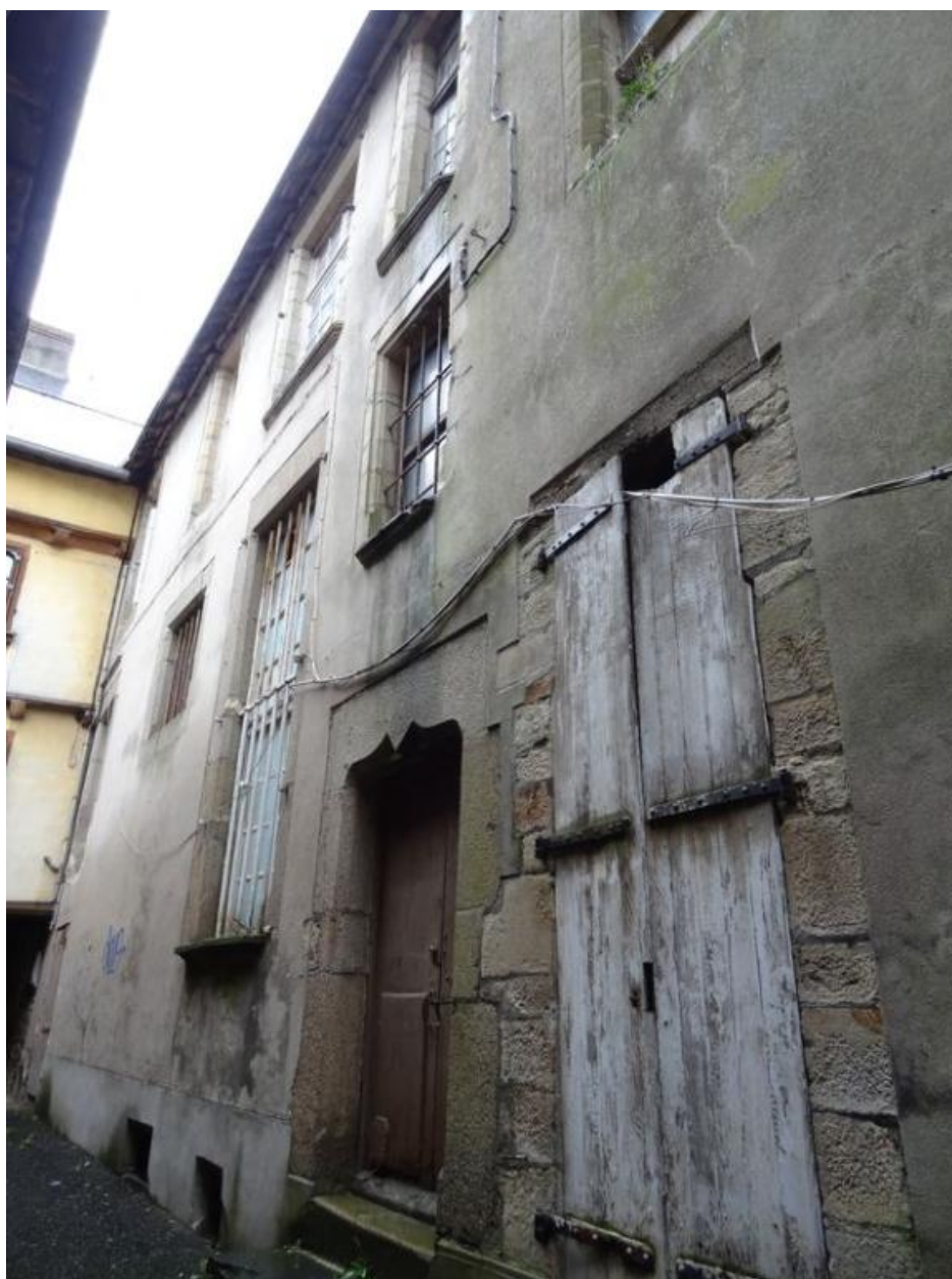
Vue générale nord de la façade ouest
