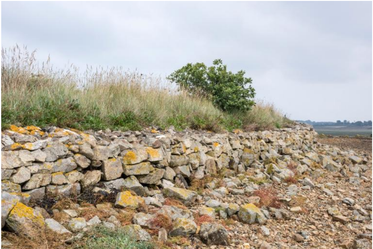
Mur de soutènement surmonté de bethune maritime ( Beta vulgaris subsp. maritima ) et d'herbacées, au niveau de la façade sud du Palud
