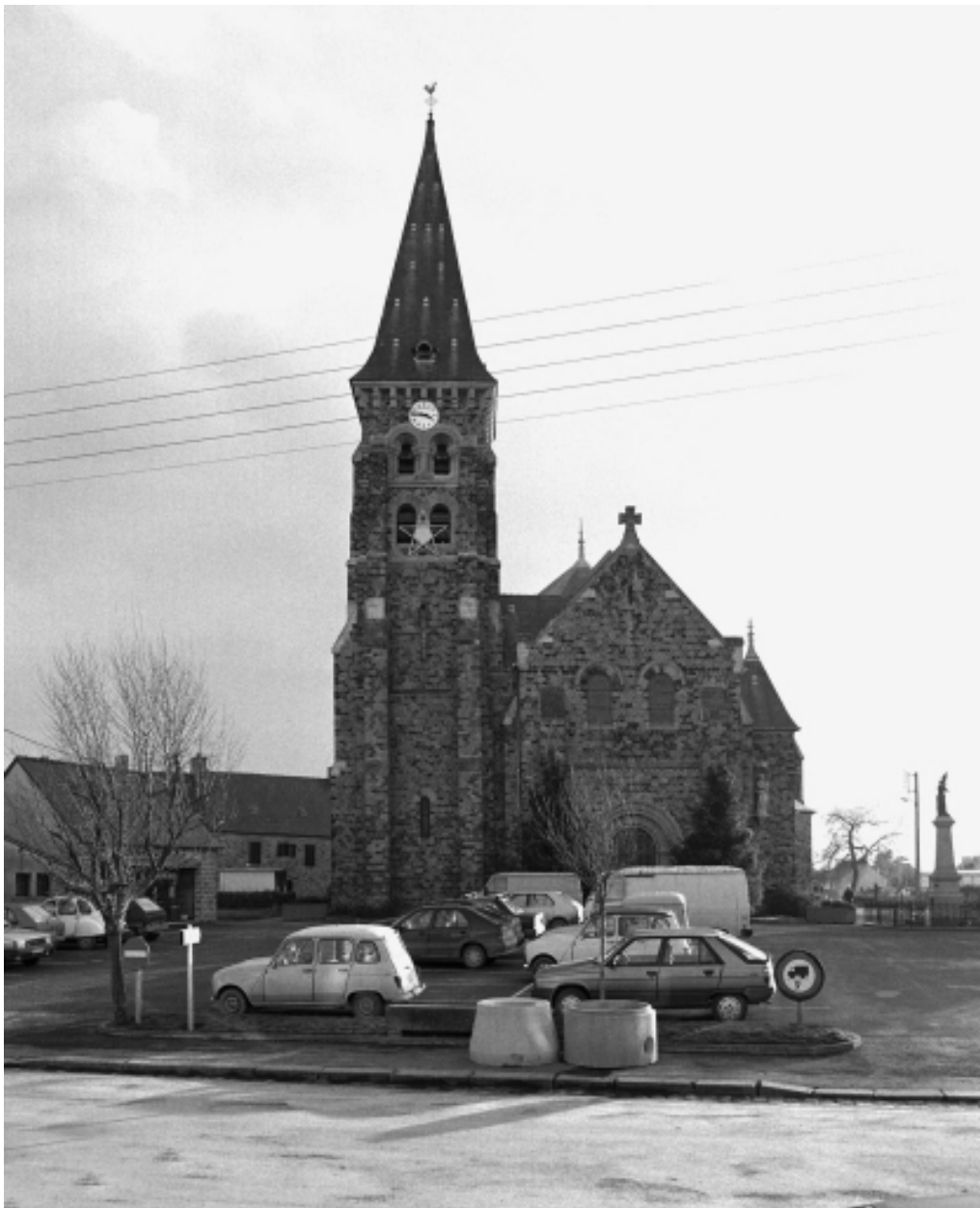
Elévation ouest : vue générale
