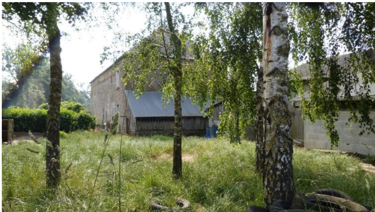
Vue nord ouest du bâtiment principal
