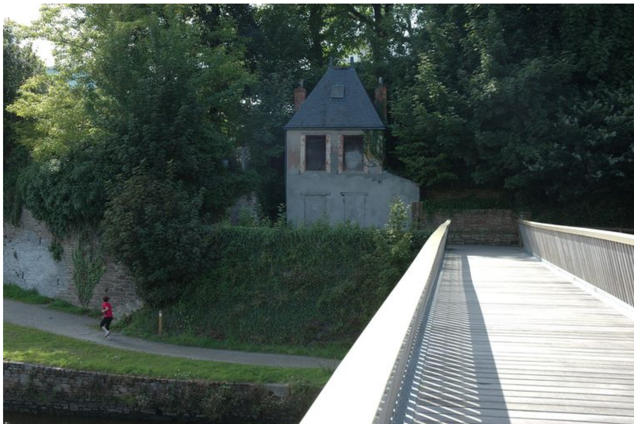
Vue de la passerelle permettant de franchir la Penfeld. Dans l'axe, corps de garde couvert en pavillon (état en 2005)
