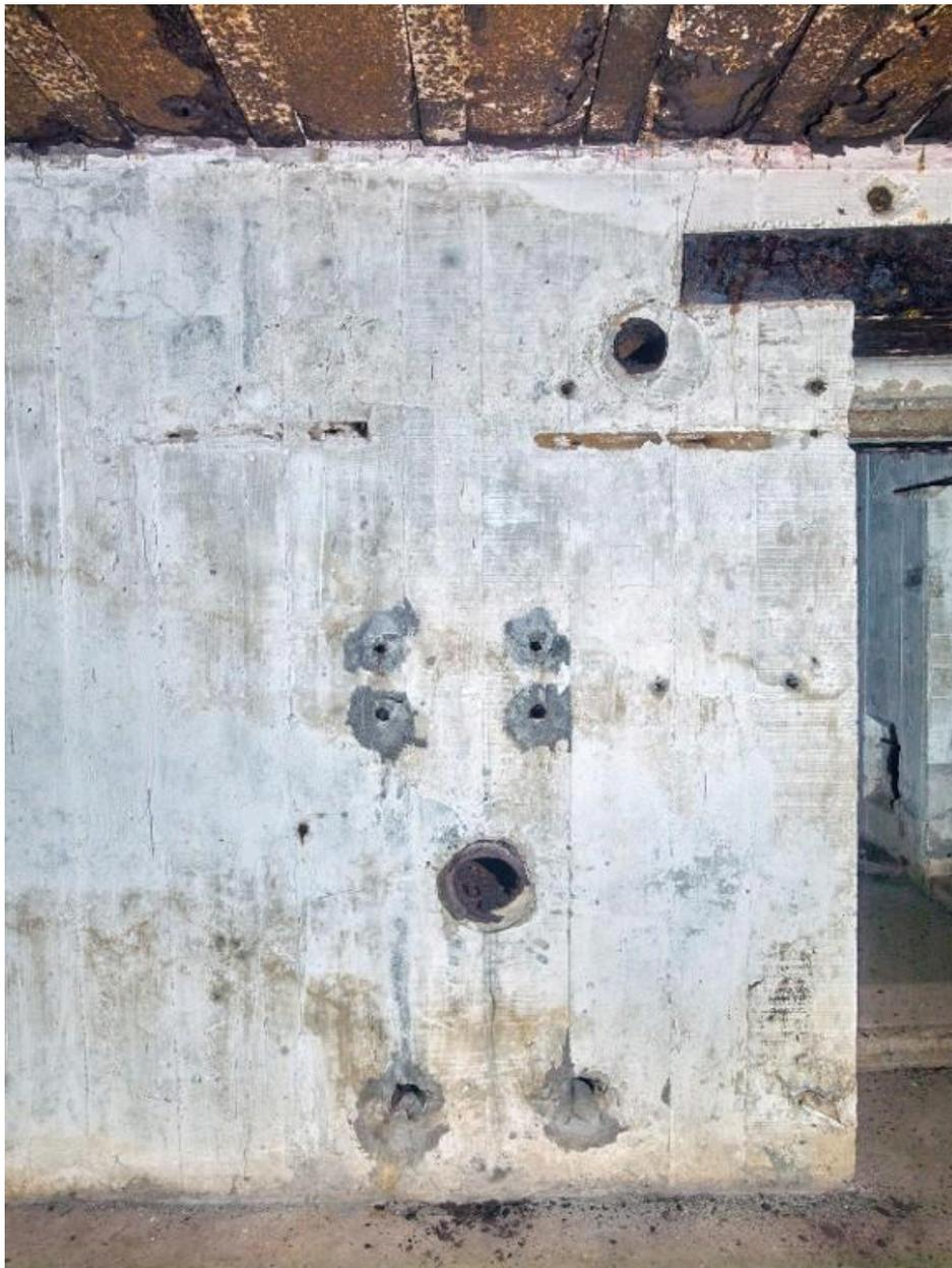
Vue de la salle de garde sud, traces de l'emplacement du système de ventilation sur le mur de refend. Les murs - peints en blanc - sont dotés de tasseaux posés à intervalle régulier
