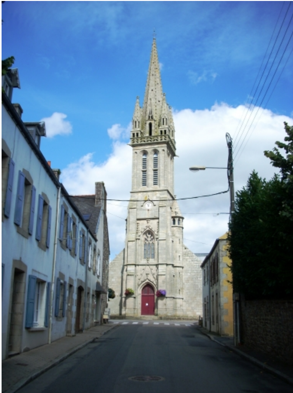
Plouigneau, église paroissiale Saint-Ignace : vue générale ouest
