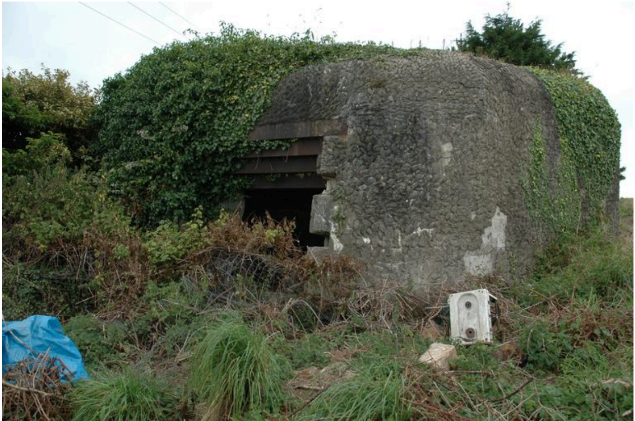
Vue générale de l'une des quatre casemates de type 669 : côté embrasure (état en 2008)
