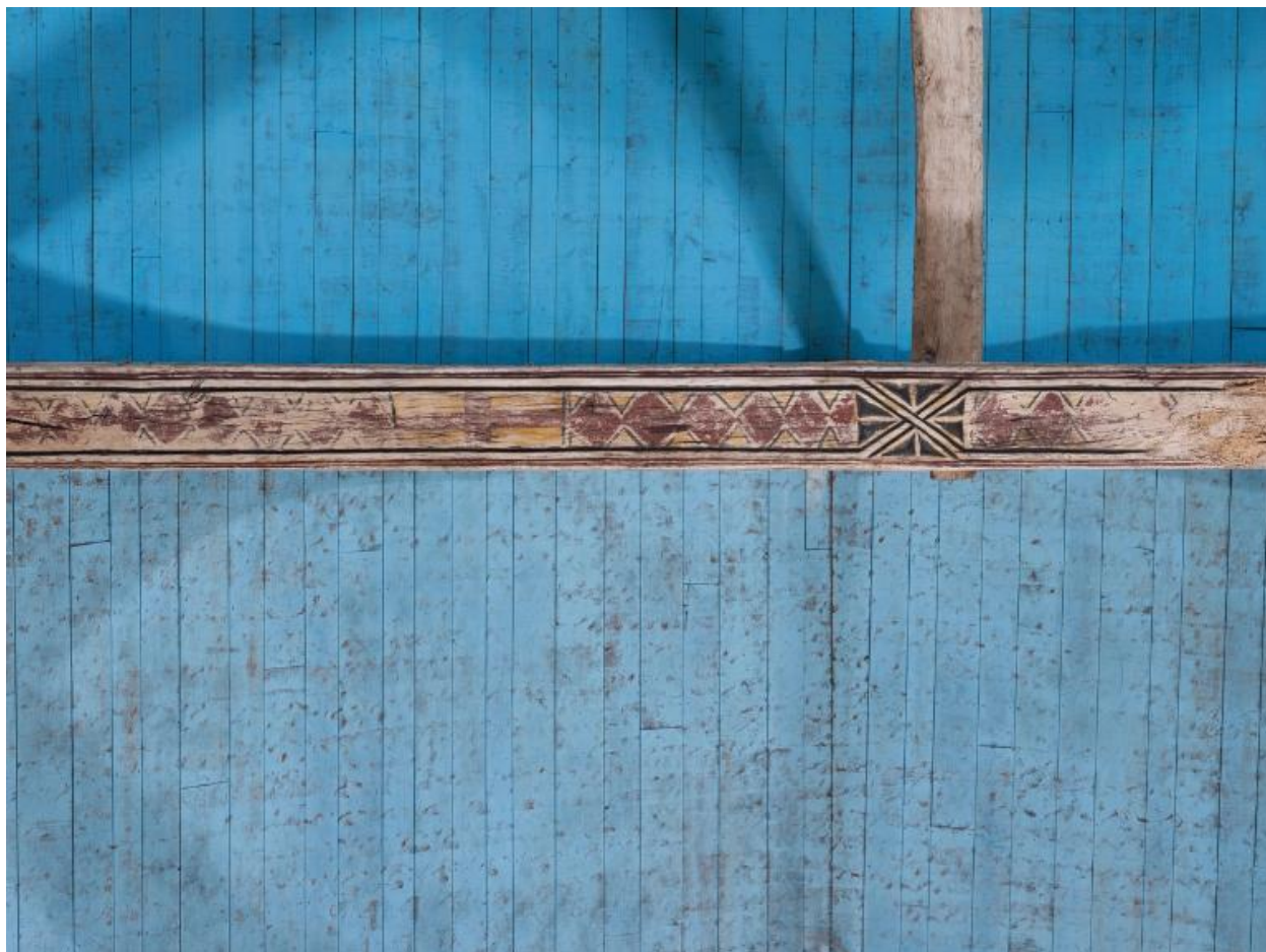
Charpente de la nef ; entrain à décor de losanges et de croix
