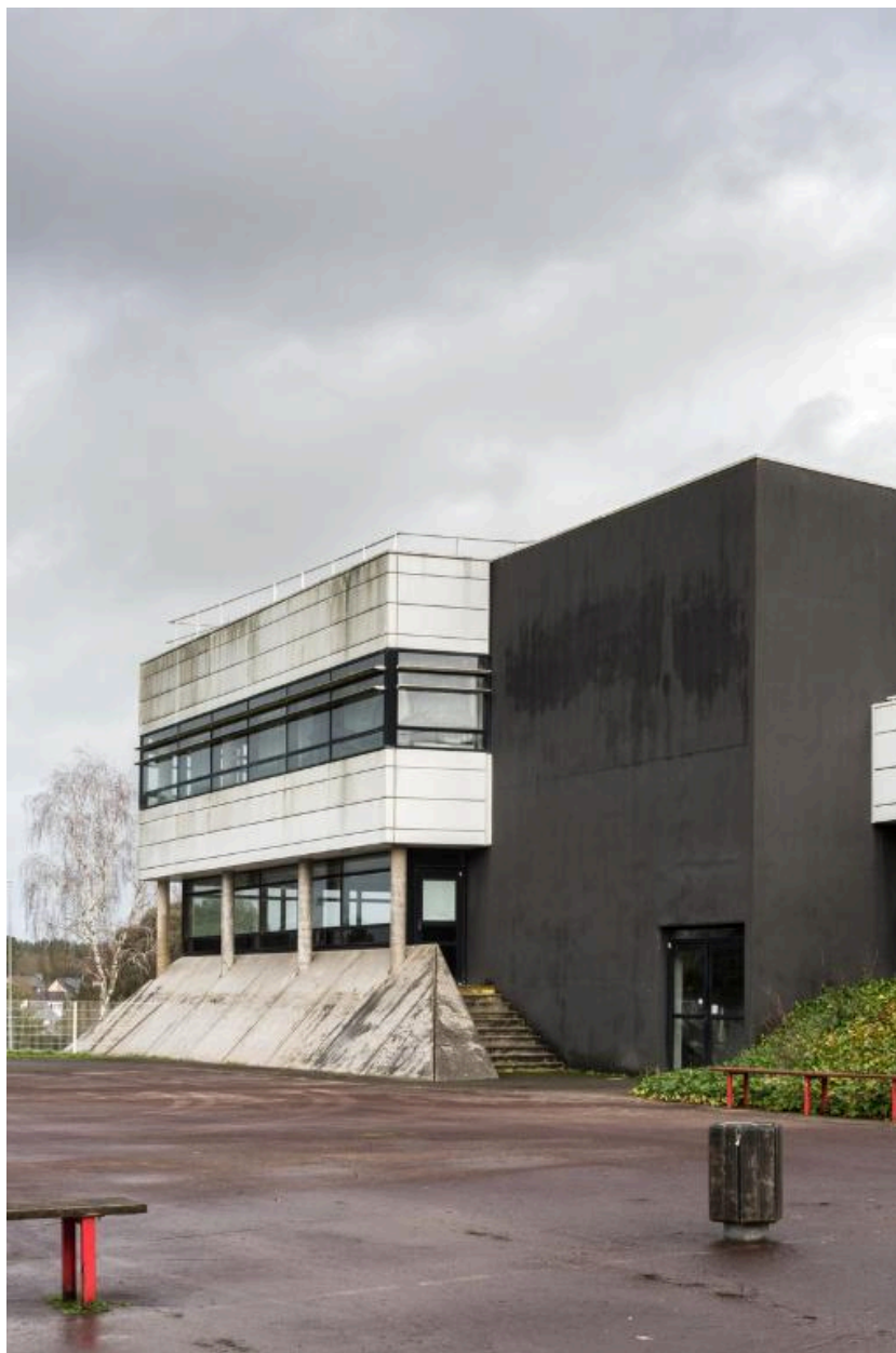
Façade ouest de l'aile nord du bâtiment multifonctions. Philippe Brulé et Marc Quéré, architectes, 1997.
