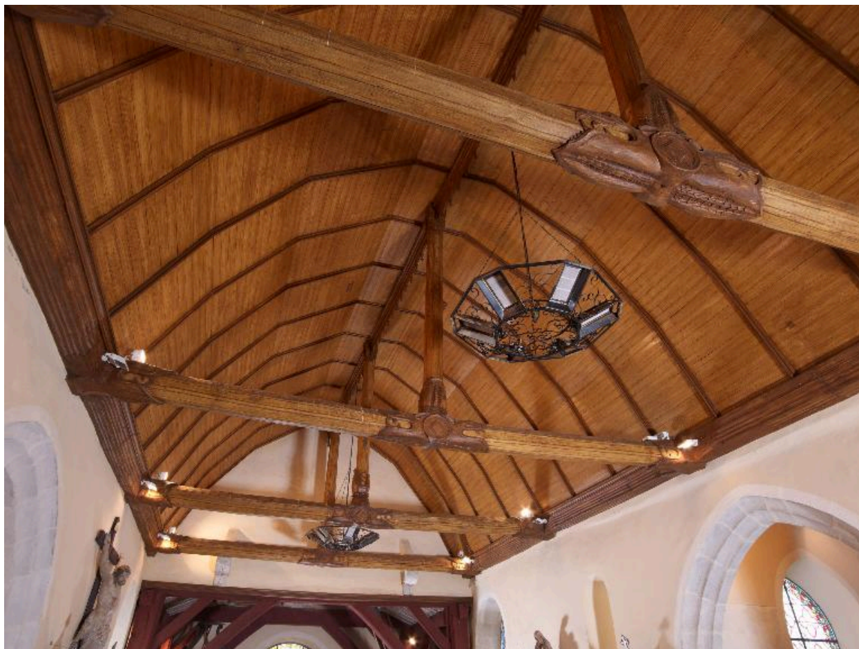
Charpente de la nef
