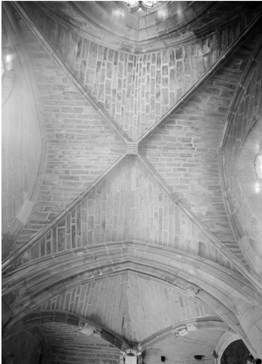
Croisillon sud, vue axiale de la voûte.
