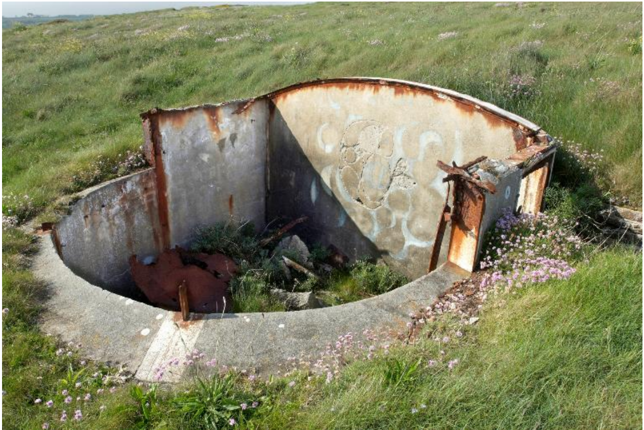
Vue du poste de télémétrie de l'une des batteries d'artillerie de côte pour télémètre Audouard (état en 2009)
