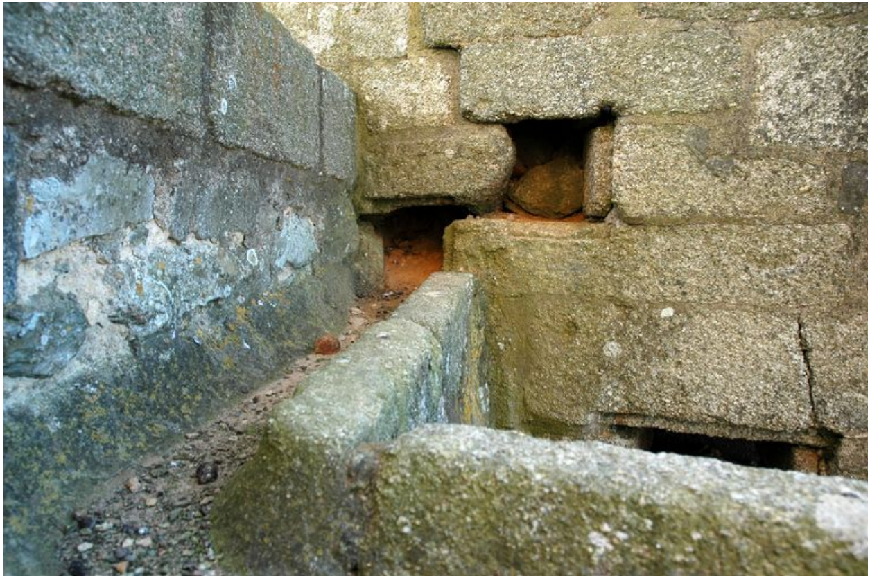
Vue de la goulotte de réception des boulets rouges (état en 2005)
