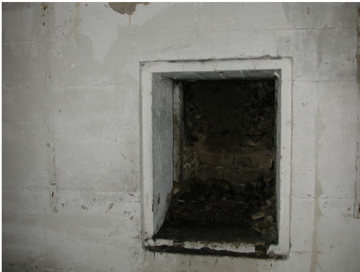
Vue intérieure : sortie de secours (état en 2002)
