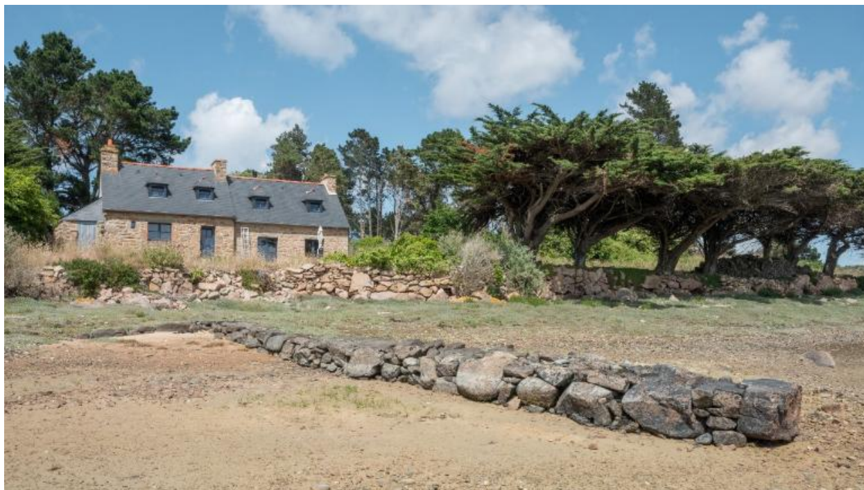
Jetée et mur de soutènement en pierre sèche au sud de l'île Balanec
