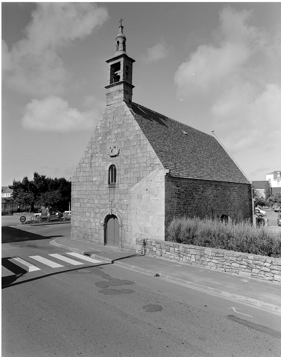
Elévation sud-ouest, vue générale
