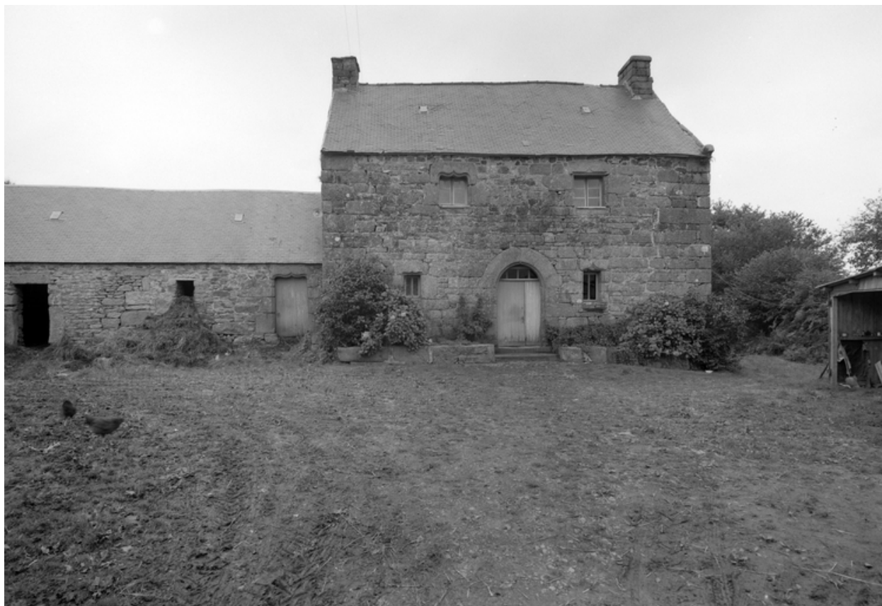
Vue générale de la façade sud du logis
