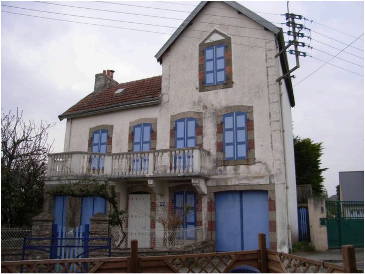
Vue générale de la villa 15 rue des Grands-Sables
