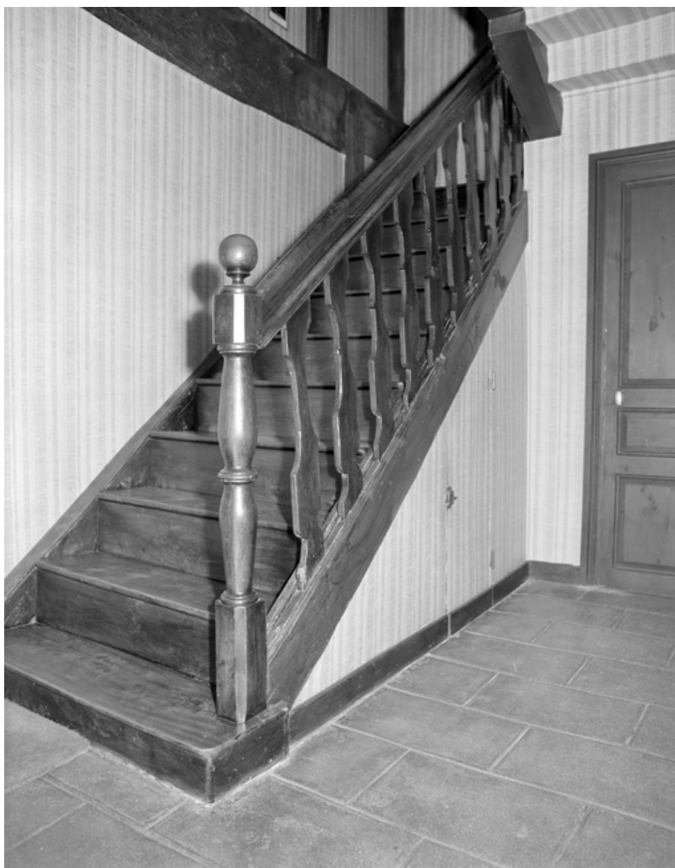
Escalier : rampe et balustres
